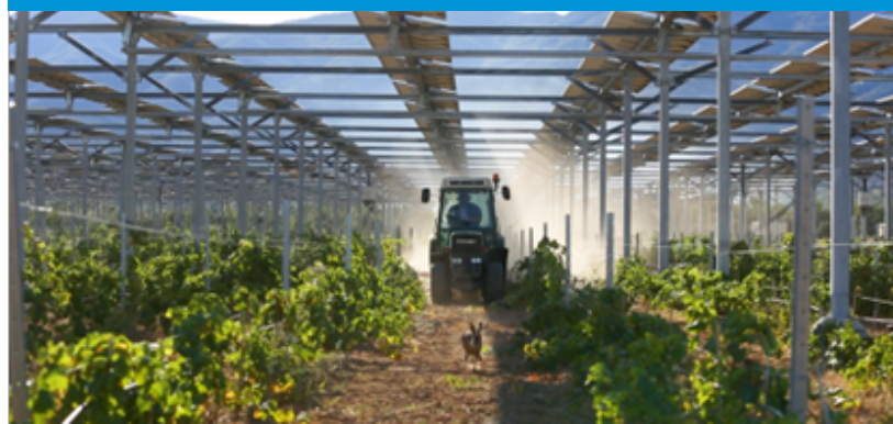
Agrivoltaïque – 100 kW à 1MW Interconnecté au réseau de distribution
