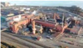
*L'usine de bouletage passera d'une production d'un peu plus de 4 Mt de boulettes en 1979 à une production annuelle d'environ 10 Mt aujourd'hui, dont environ 2,5 Mt de boulettes à « réduction directe », utilisées pour la fabrication d'acier à faible empreinte carbone.*
